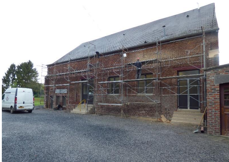
Rénovation façade de la salle de musique
